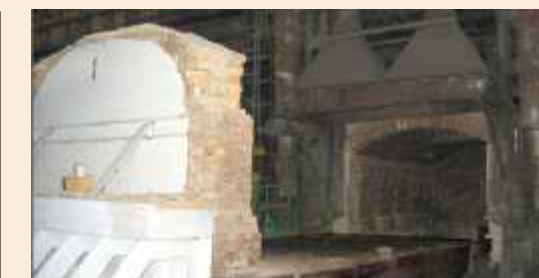
Печь до реконструкции
